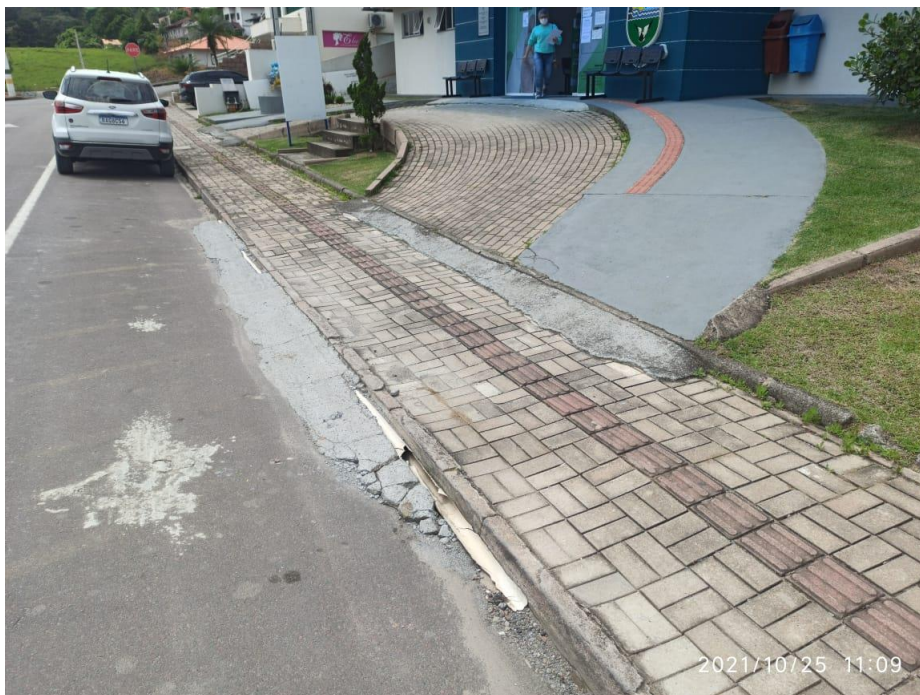
Fig 07 – Local da readequação da calçada.
