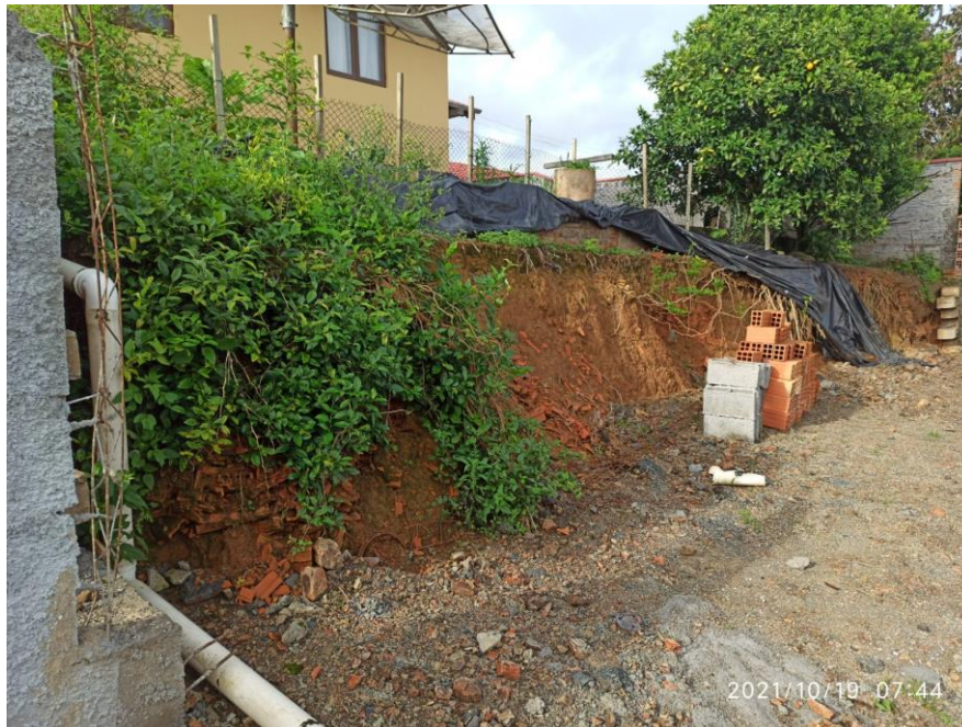
Fig 02 – Local da obra do muro.
