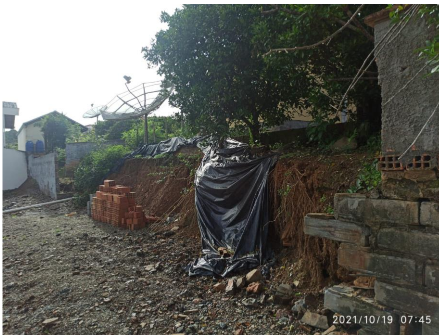
Fig 03 – Local da obra do muro.
