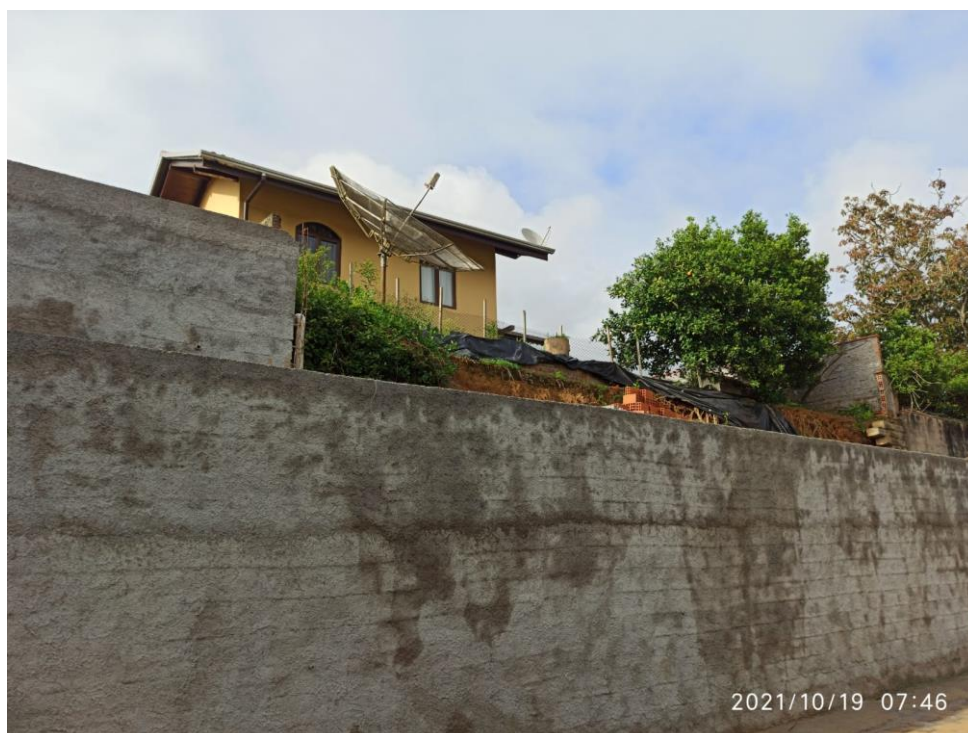
Fig 05 – Local da obra do muro.
