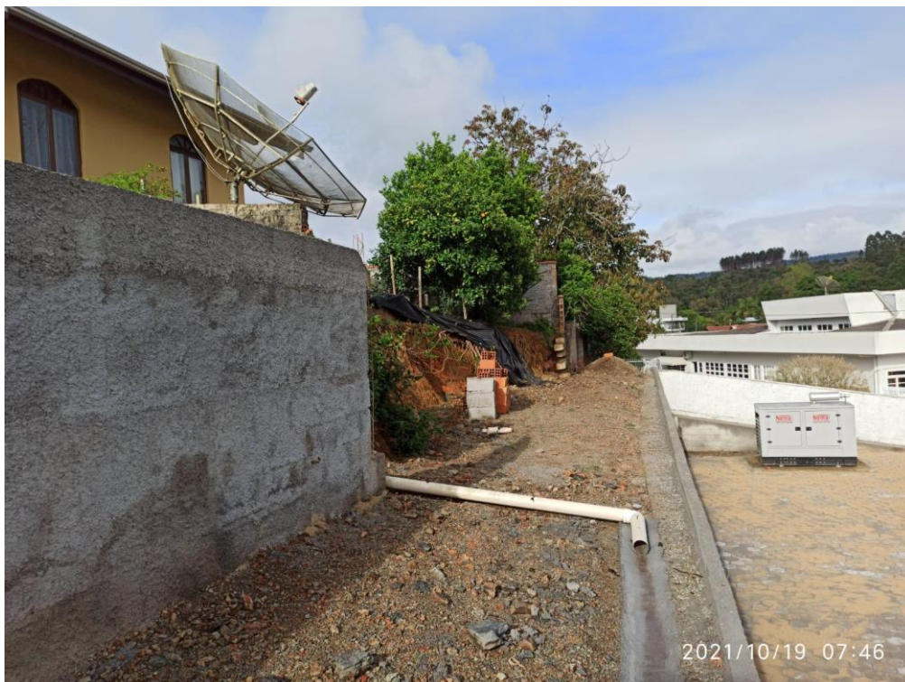
Fig 04 – Local da obra do muro.
