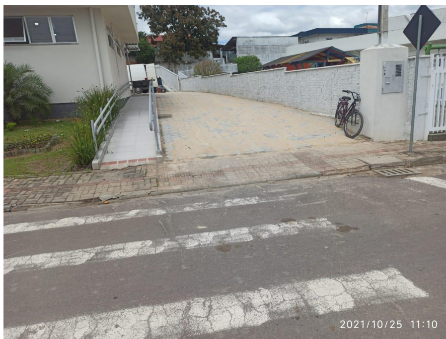
Fig 09 – Local da readequação da calçada.
