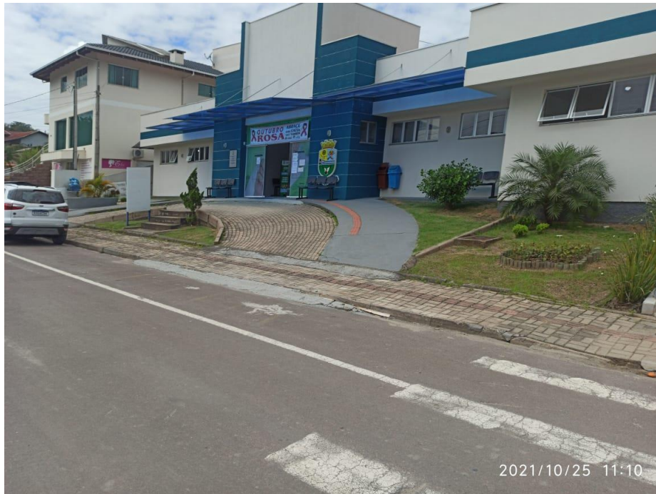
Fig 06 – Local da readequação da calçada.
