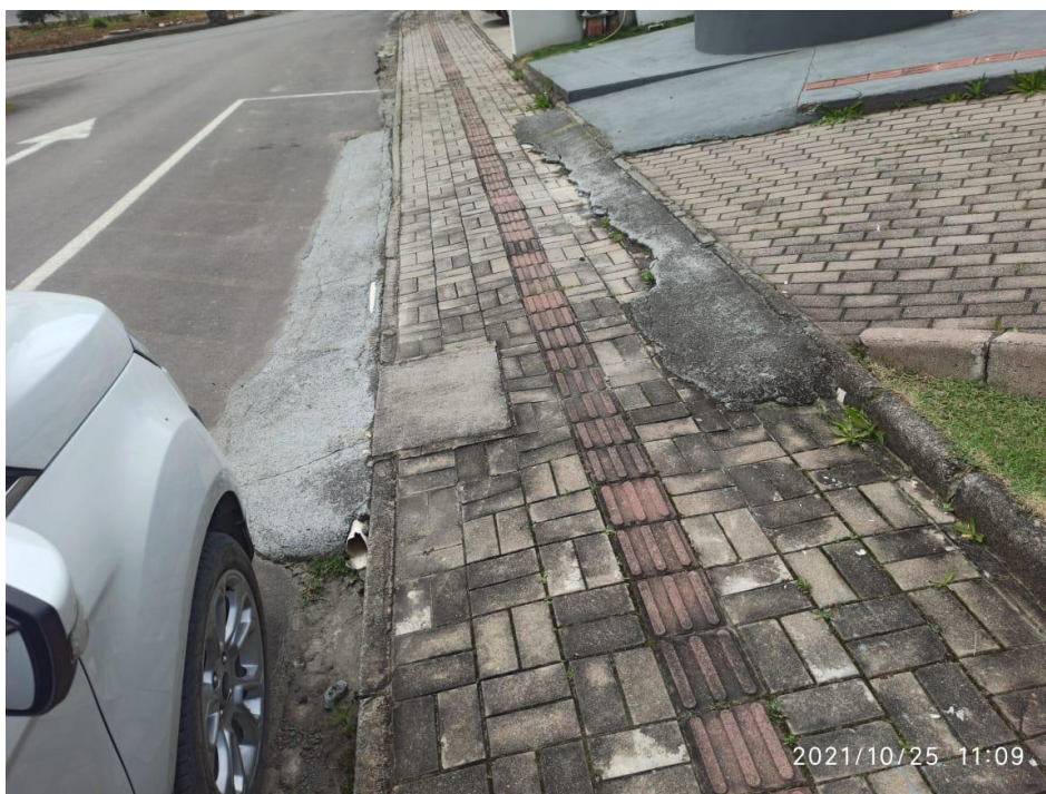
Fig 08 – Local da readequação da calçada.
