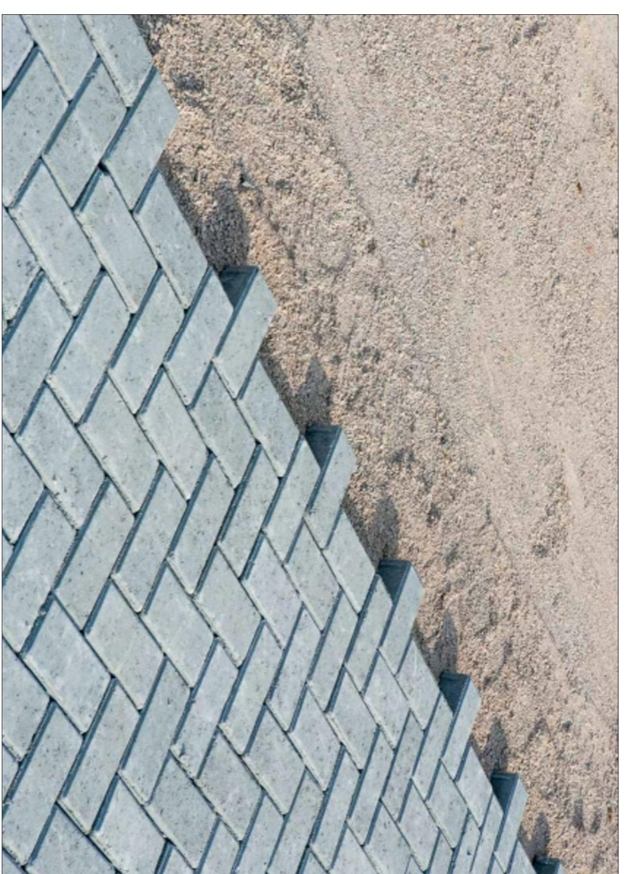
DETALHES PAVER DE CONCRETO – COR CINZA
