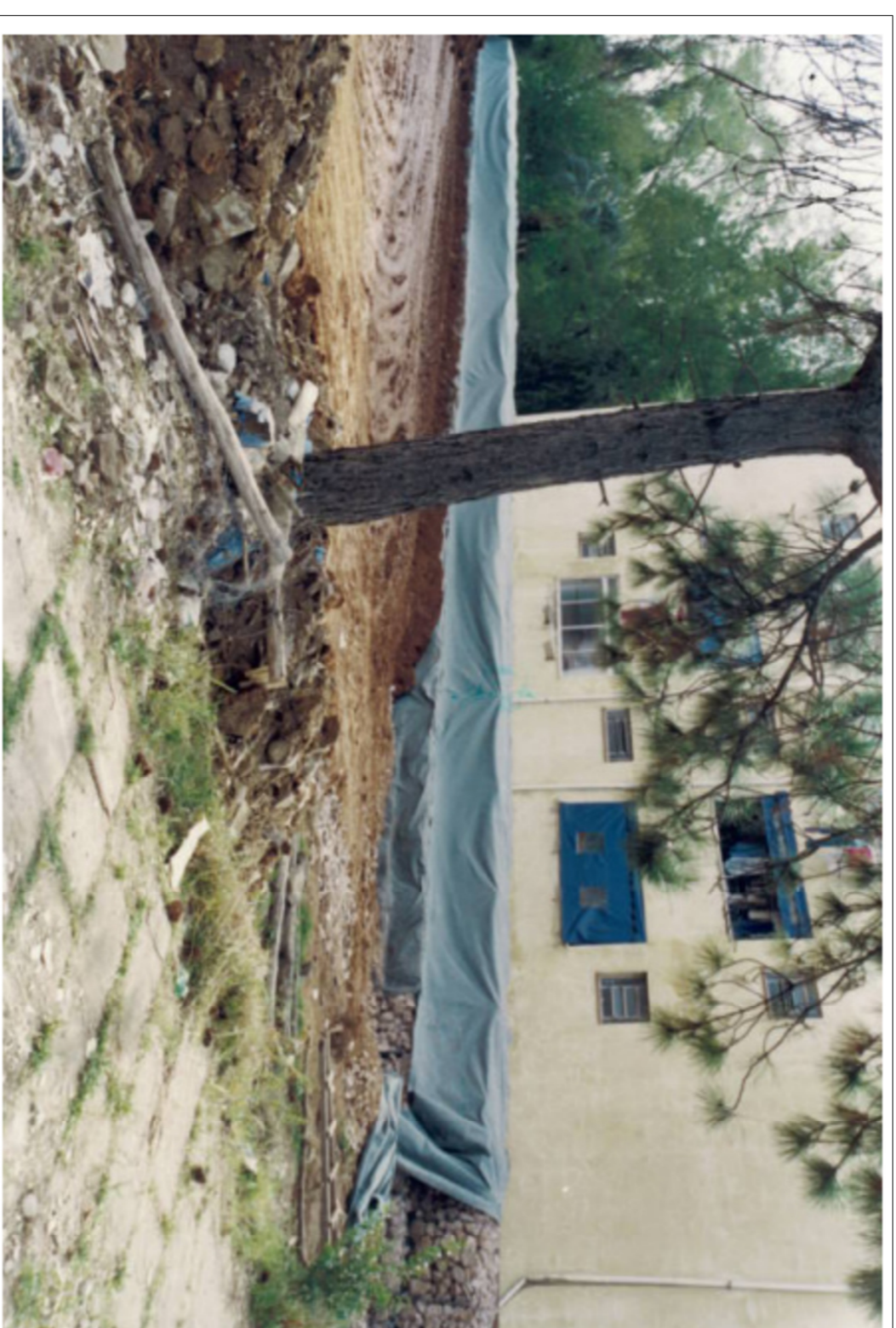
DETALHE MANTA GEOTEXTIL – APLICAÇÃO / ILUSTRATIVA – FONTE GOOGLE
